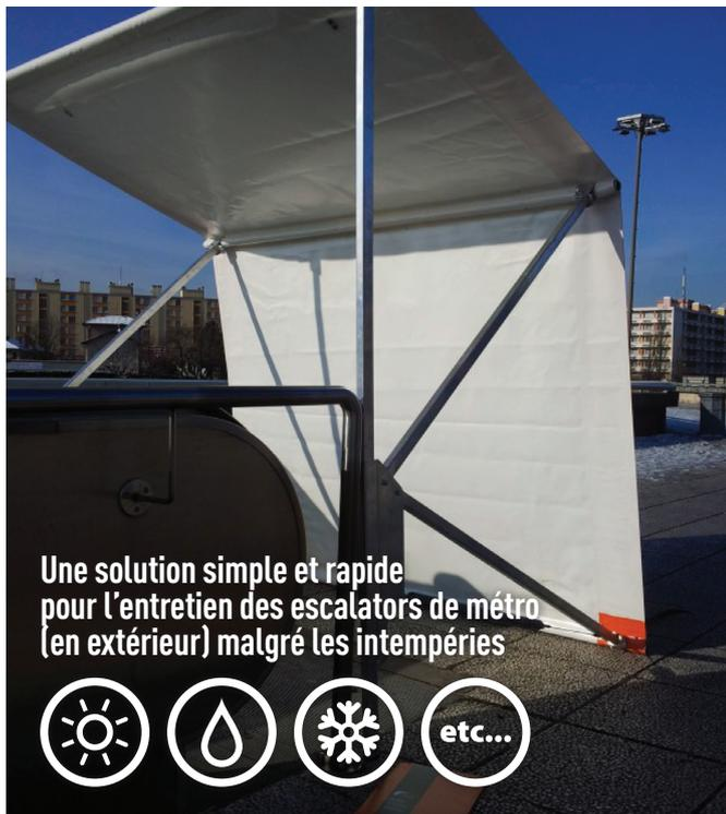
Une solution simple et rapide pour l'entretien des escalators de métro (en extérieur) malgré les intempéries
